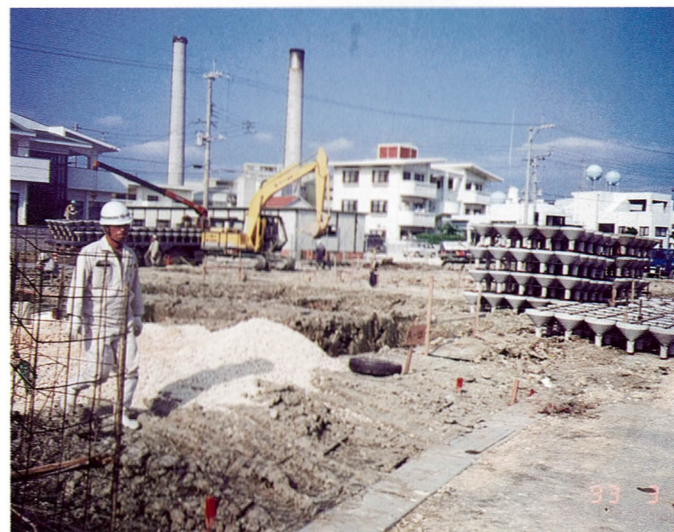
沖縄県住宅供給公社平園ハイツ新築工事（西原町地内）
