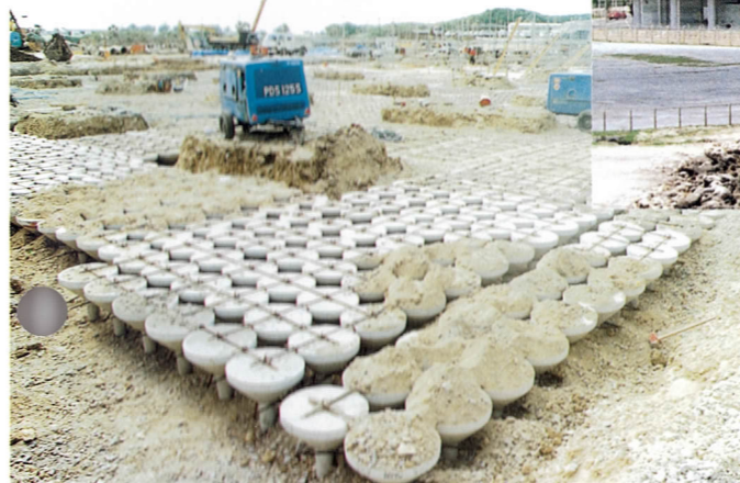
▼ フリーゾーン工事風景
