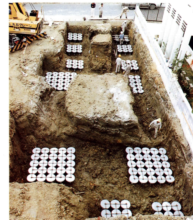
▲ 住宅基礎工事（名護市）
