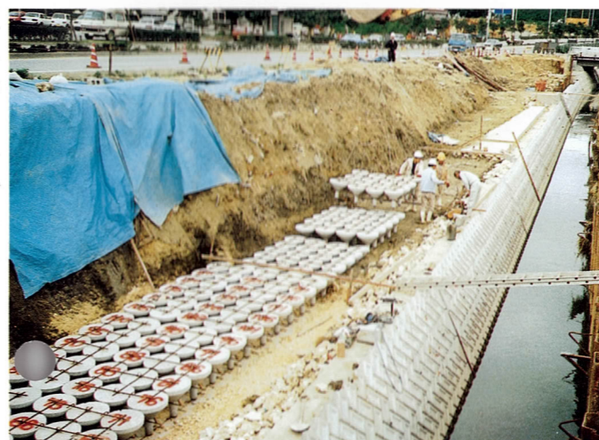
▲ 牧港川河川改修工事 重力式擁壁基礎工事
