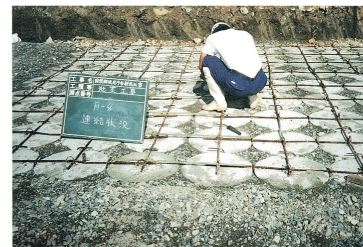
国頭郵便局庁舎新築工事（郵政省）
