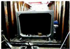
製品寸法: 2000×1500×2000 mm 直線施工(特殊施工)
