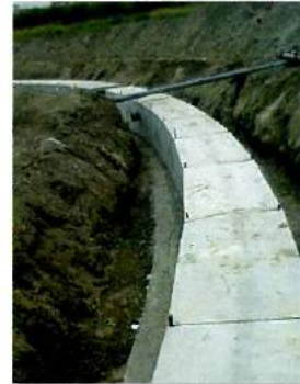
製品寸法: 800×800×2000, 600×600×2000, 500×500×2000 曲線施工
