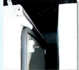
TBジョイントバー挿入状況
