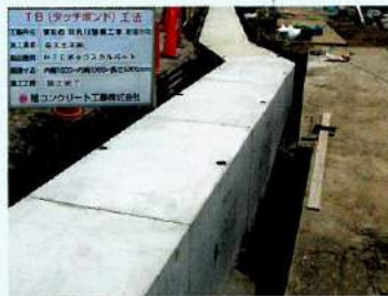
曲線部も直線部と同じ施工!
