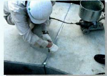
上部より頂版天端部へ注入(曲線部)
