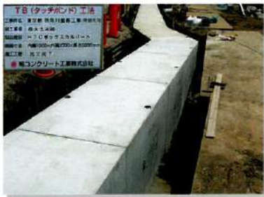
製品寸法: 1000×1000×2000 mm 直線及び曲線施工
