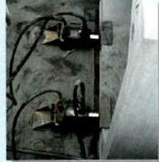
ジャッキによる押し込み状況
