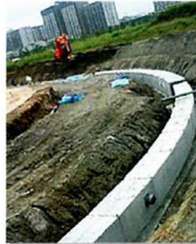
製品寸法: 800×800×2000, 600×600×2000, 500×500×2000 曲線施工
